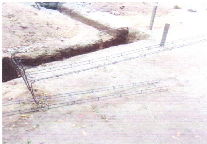
FOTO 01 - ESCAVAÇÃO MANUAL PARA BLOCO DE COROAMENTO OU SAPATA (INCLUINDO ESCAVAÇÃO PARA COLOCAÇÃO DE FÔRMAS). AF_01/2024
