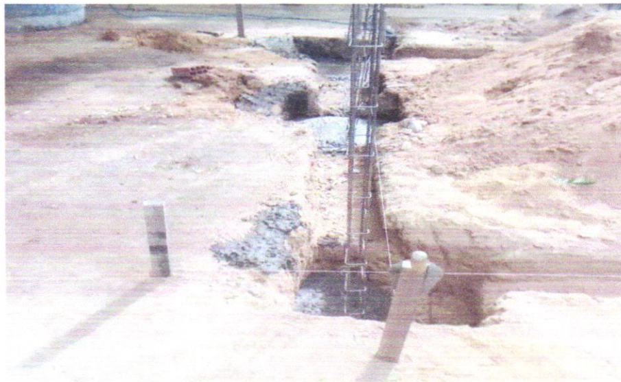
FOTO 03 - ARMAÇÃO DE PILAR OU VIGA DE ESTRUTURA CONVENCIONAL DE CONCRETO ARMADO UTILIZANDO AÇO CA-50 DE 10,0 MM - MONTAGEM. AF_06/2022
