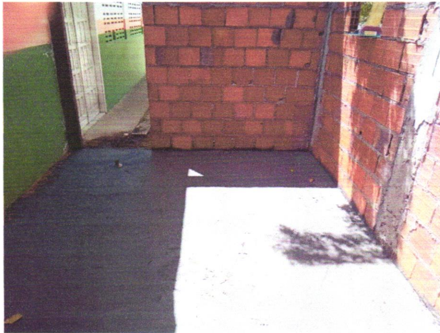
FOTO 11 - PISO EM CONCRETO 20 MPA PREPARO MECÂNICO, ESPESSURA 7CM. AF_09/2020
