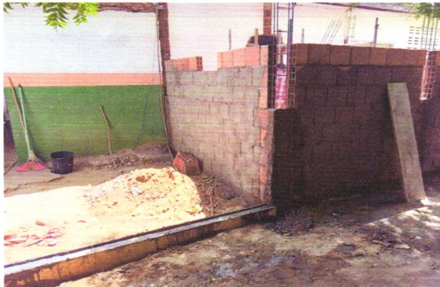
FOTO 05 - Alvenaria bloco cerâmico vedação, 9x19x24cm, e=9cm, com argamassa t5 - 1:2:8 (cimento/cal/areia), junta=1cm - Rev.09
